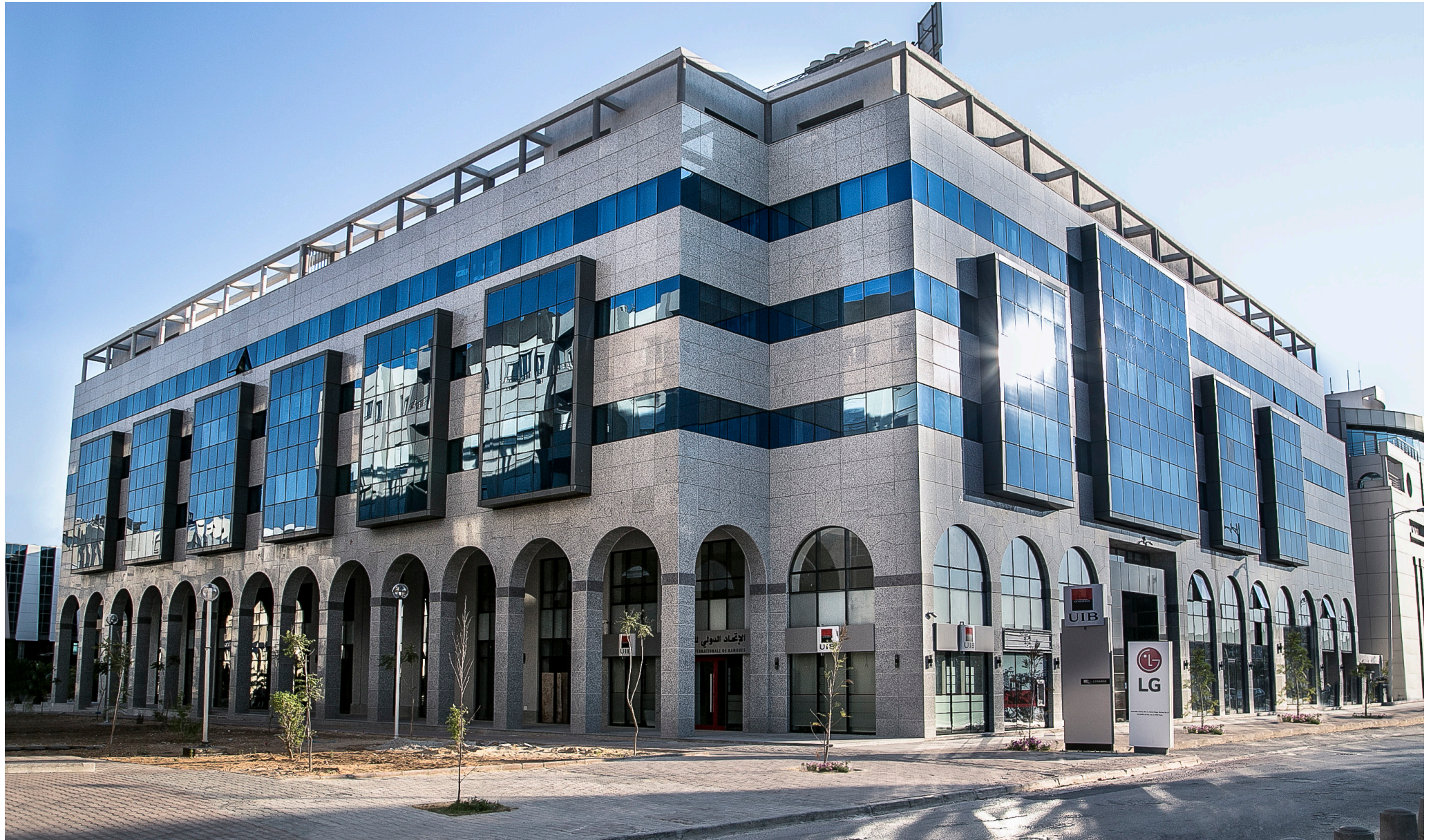
Bât. Lac II / Lac II building
